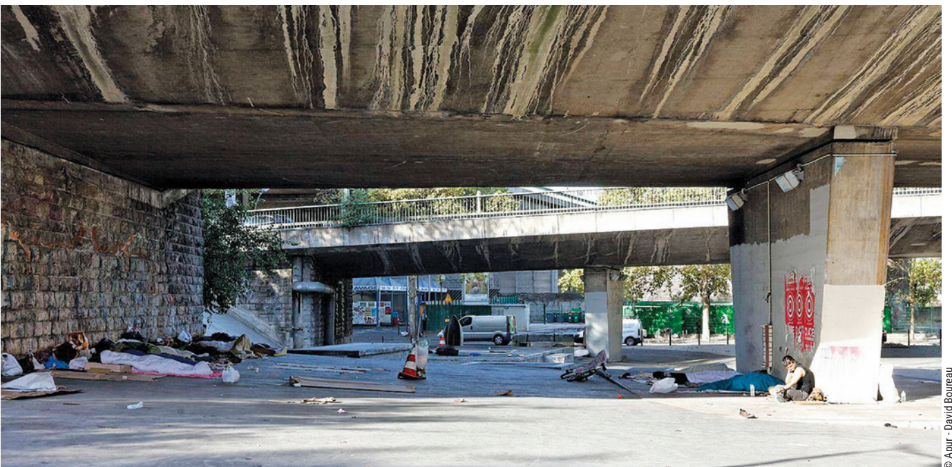
Espace public sous le Boulevard périphérique, impasse Marteau (Porte de la Chapelle - Charles Hermite, 18 e )
